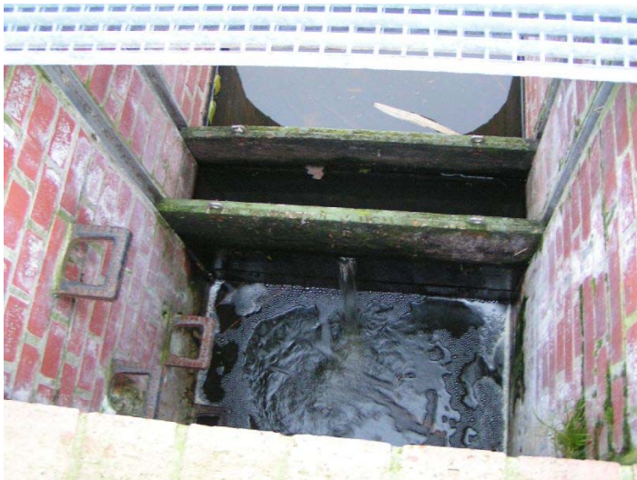
Bild 44: Ablaufbauwerk Mönch, TKA Walbeck
