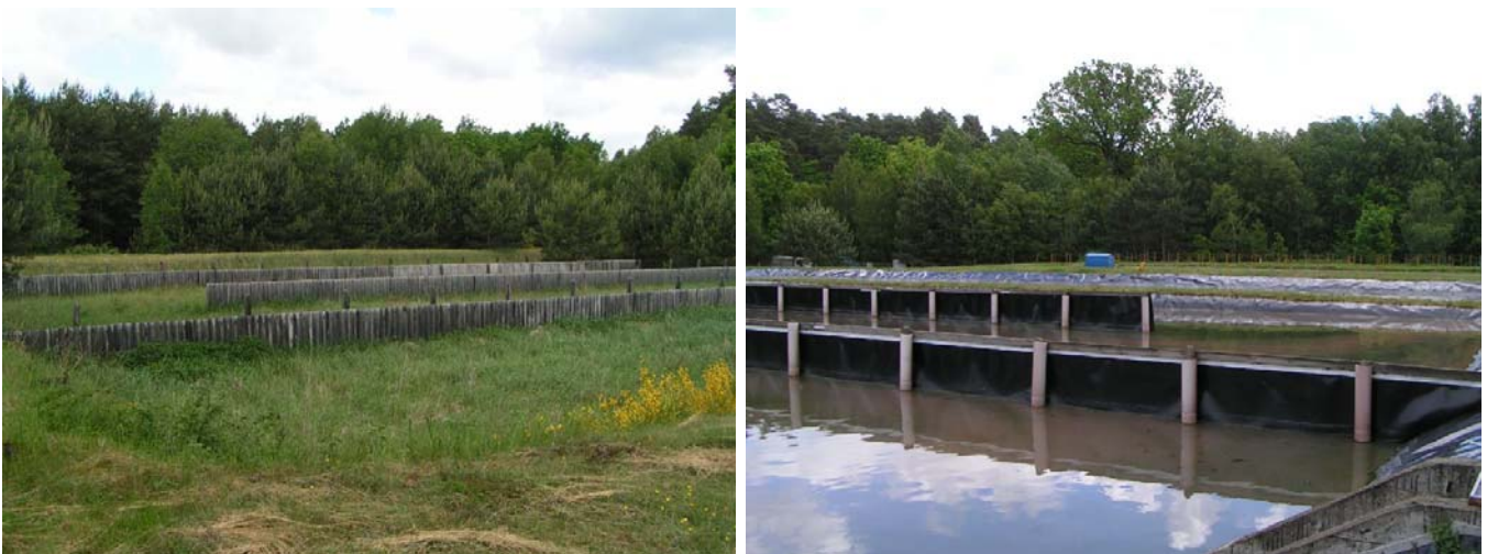
Bild 46: Leitdammkonstruktionen vorher (links) und nachher (rechts), TKA Netzeband
