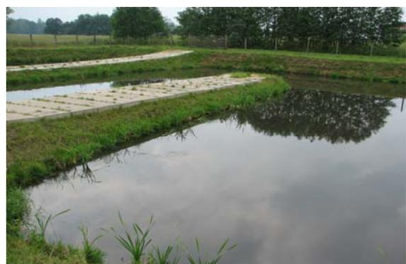
Abb.: 12 Leitdämme / Kiesbänke (links) [8] und befahrbare Leitdämme (rechts) zur Ver-besserung der Strömungscharakteristik
