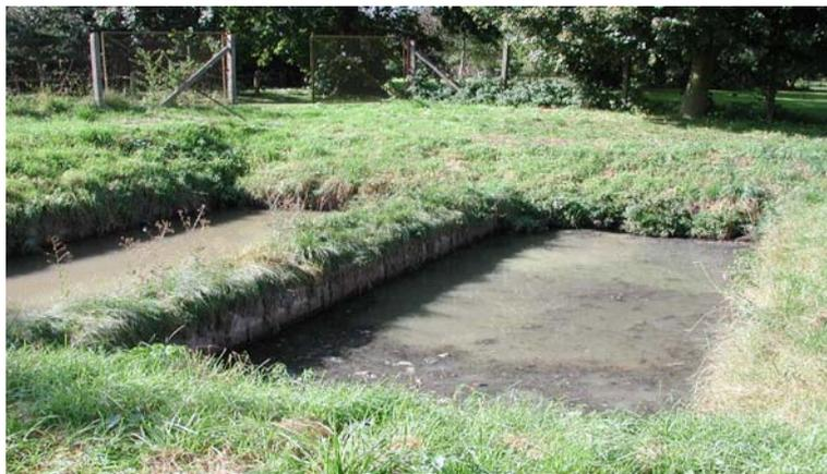
Abb.: 20 Einfache Absetzbecken in Teichbauweise [6]
