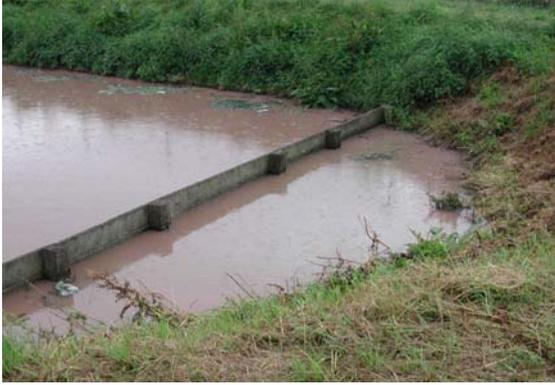
Abb.: 7 Tauchwand im Ablaufbereich eines Absetzteiches, Rotfärbung durch Purpurschwefelbakterien [5]
