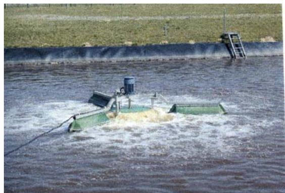
Abb.: 13 Tauchbelüfter (links) [8], Oberflächenbelüfter (rechts) [8]
