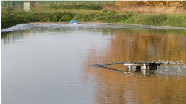
Abb.: 26 Rückführung des Abwassers aus dem Nachklärteich in den 1. belüfteten Teich (Verregnung) [7]
