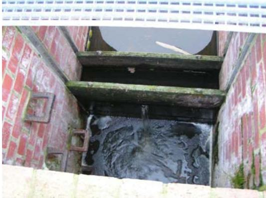
Abb.: 6 Justierung des Wasserpegels durch Veränderung der Anzahl der Damm-balken im Ablaufbauwerk Mönch [7]
