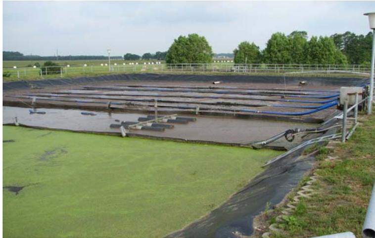
Abb.: 32 Belebtschlammanlage in Teichbauweise (System BIOLAK)
