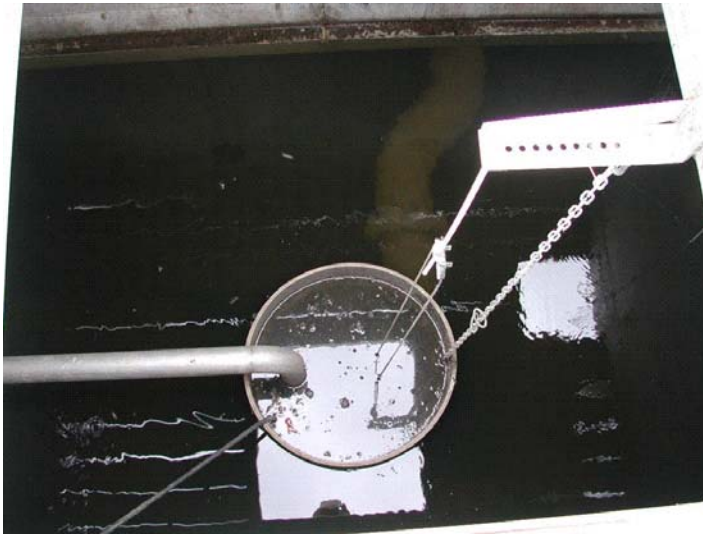
Bild 31: Emscher Brunnen der Anlage Prießnitz
