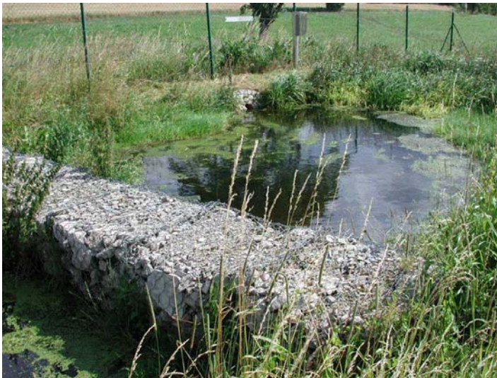
Bild 32: Ablauf der Anlage Prießnitz
