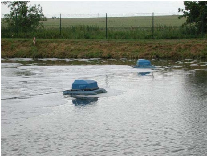
Bild 39: Dritter Teich (2) mit Belüfter, Anlage Barneberg
