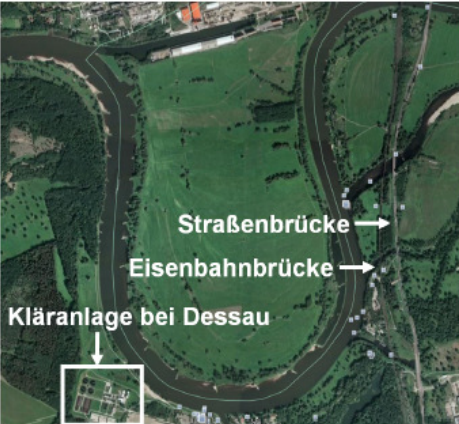
Satelliten-Bild (Quelle: Google Earth)
