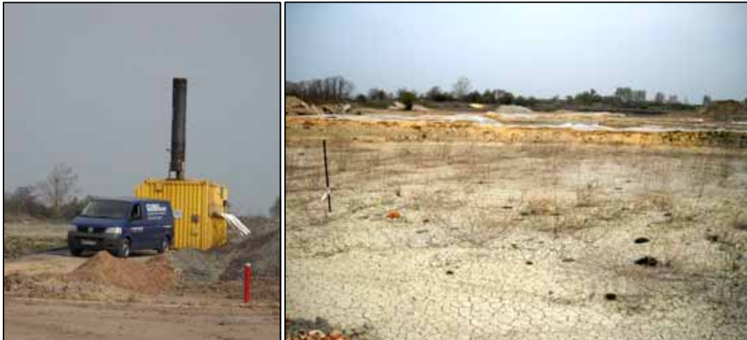
Abbildung 92: links: Grubengasfackel, rechts: verfüllte Tongrube (Aufnahmen vom 26.04.2010)
