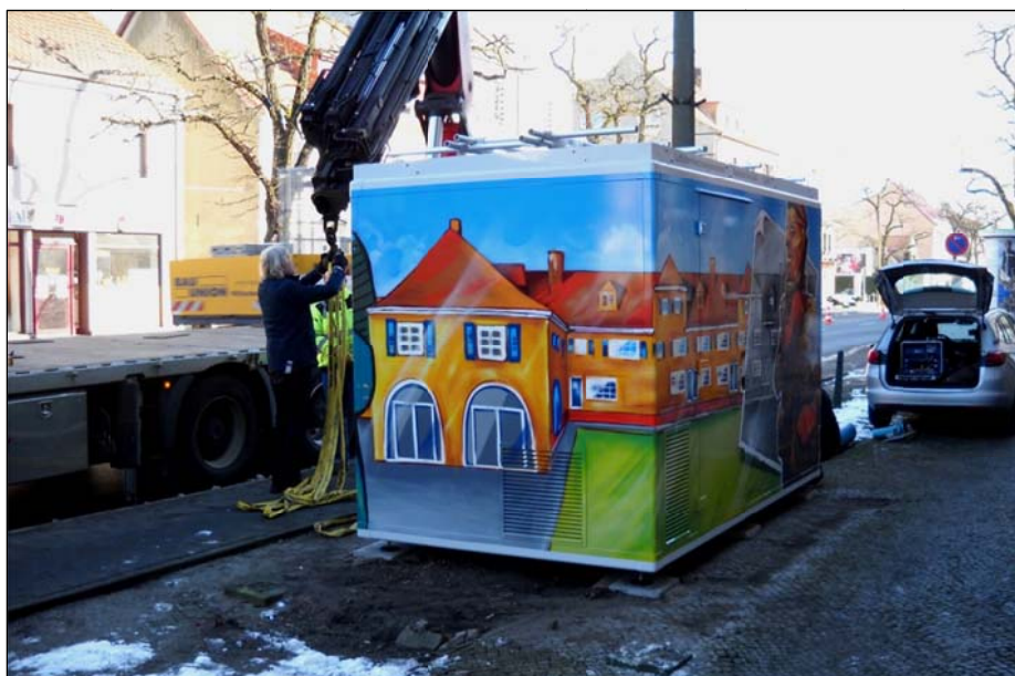
Abbildung 24: Austausch der Containerhülle der Messstation Wittenberg/Dessauer Straße im Februar 2018 (hier im Bild: Anlieferung der neuen Station)
